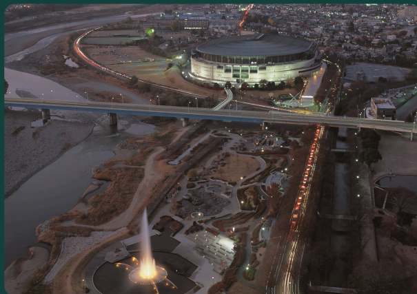
日本トーターグリーンドーム前橋
